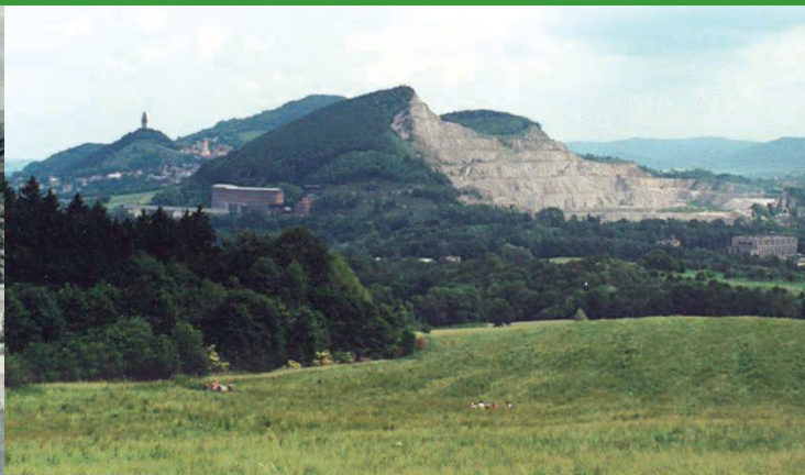
pohled na Kotouč v roce 1998
